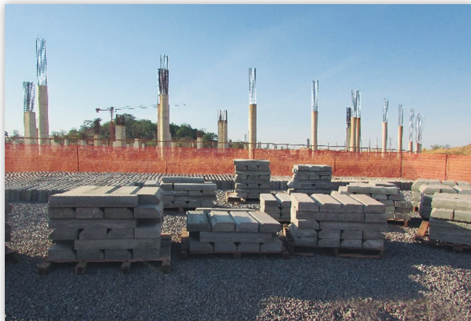
Guias feitas com o concreto e a madeira reaproveitados prontas para serem utilizadas e/ou destinadas.
